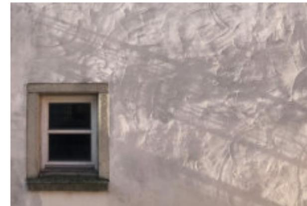
Lebendige Oberfläche: mit der Hand aufgetragener Putz (verrieben) und Fenstergewände aus Granit
