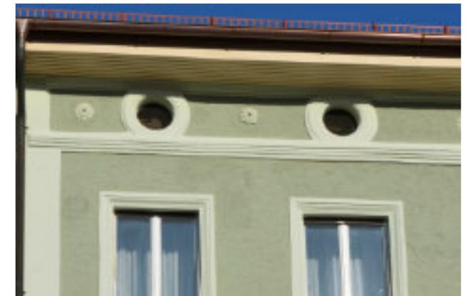
Charakteristisch: die Kniestock-Befensterung als Belüftungsöffnung und Schmuckelement
