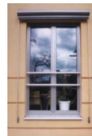
Markisolette mit textiler Bespannung (kann auch nachgerüstet werden).
